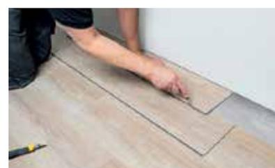
11. De seguida, deslize o segundo painel por baixo do encaixe fêmea, num ângulo de 25°, no encaixe macho da fila anterior. Posicione o canto esquerdo contra o painel anterior, e de seguida deixe cair o lado mais curto no perfil do topo do painel anterior, empurre para baixo e pressione para a posição certa, utilizando um rolo manual. Repita até chegar ao fim da fila. Não martele as juntas finais no lugar.
