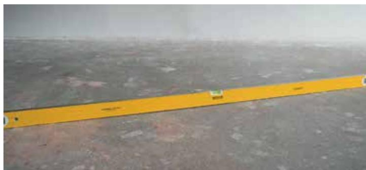
Deve ser aplicado um contraplacado adequado, ou um composto de nivelamento, por forma a garantir que não existem irregularidades a emergir na superfície do pavimento. Contudo, a seleção de um material adequado,
